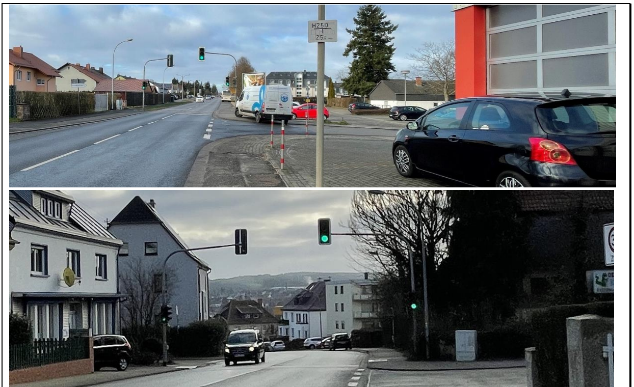
Abbildung 23: Bedarfs-Lichtzeichen-Anlage zur Sicherung der Querungen an der Einmündung Willi-Graf-Straße (oben) und der Rosenstraße (unten)
