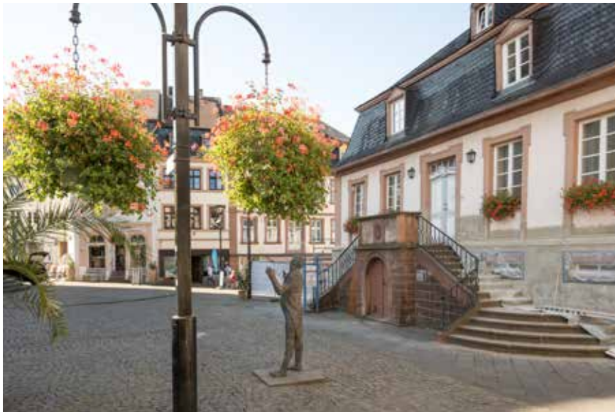
Derzeit in Sanierung befindliches Altes Rathaus am Fruchtmarkt
