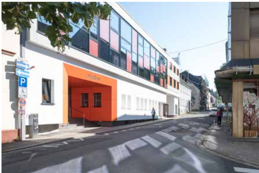
Saalbau im Bereich der Balduinstraße mit aufwertungsbedürftigem Umfeld
