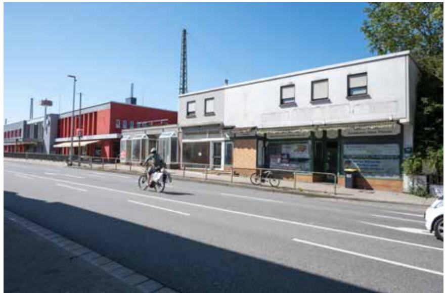
Leerstehende Gewerbeeinheiten am Bahnhof
