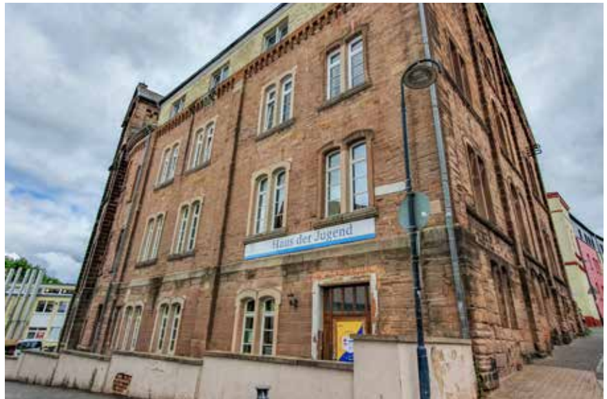
Denkmalgeschütztes Gebäude der Hospital Stiftung in der Hospitalstraße mit Sanierungs- und Aufwertungsbedarf
