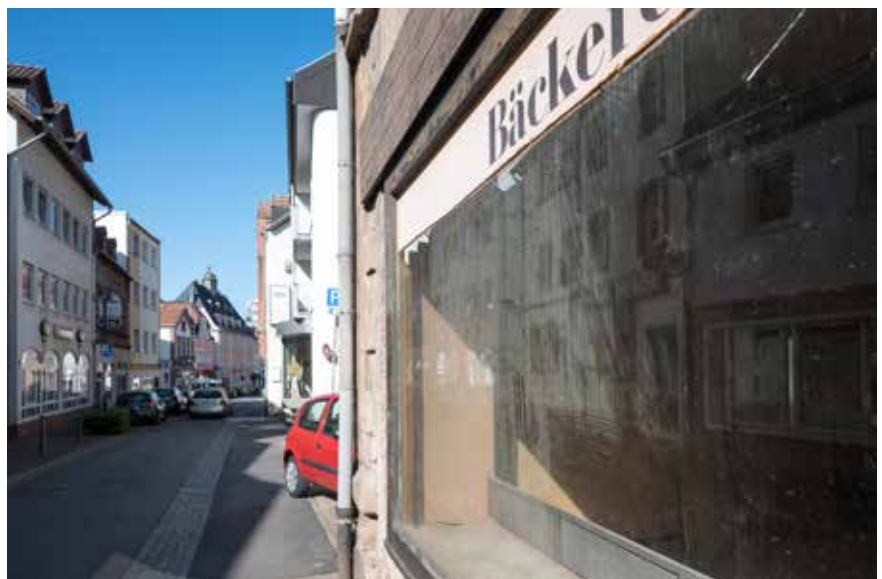
Gewerbliche Leerstände im Bereich der Balduinstraße mit stark sanierungsbedürftiger Bausubstanz
