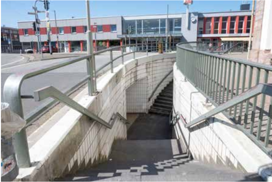
Zugang zur Unterführung Bahnhofstraße - Bahnhof
